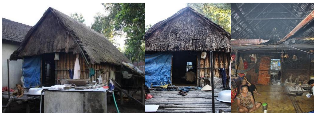
Hình 2.11. Nhà Chăm H'roi dạng mái tranh phên tre . Huyện Sơn Hòa, Phú Yên.
